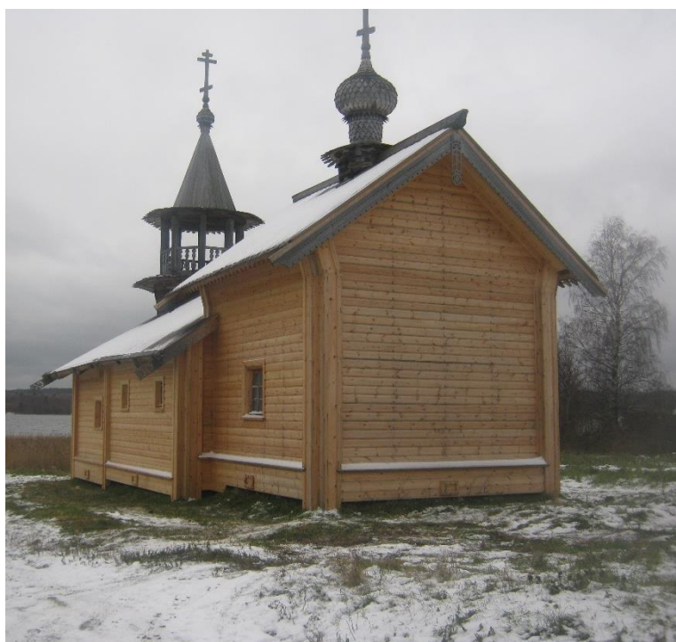
Рис. 10. Часовня Успения Богородицы на о. Кижи в обшивке
