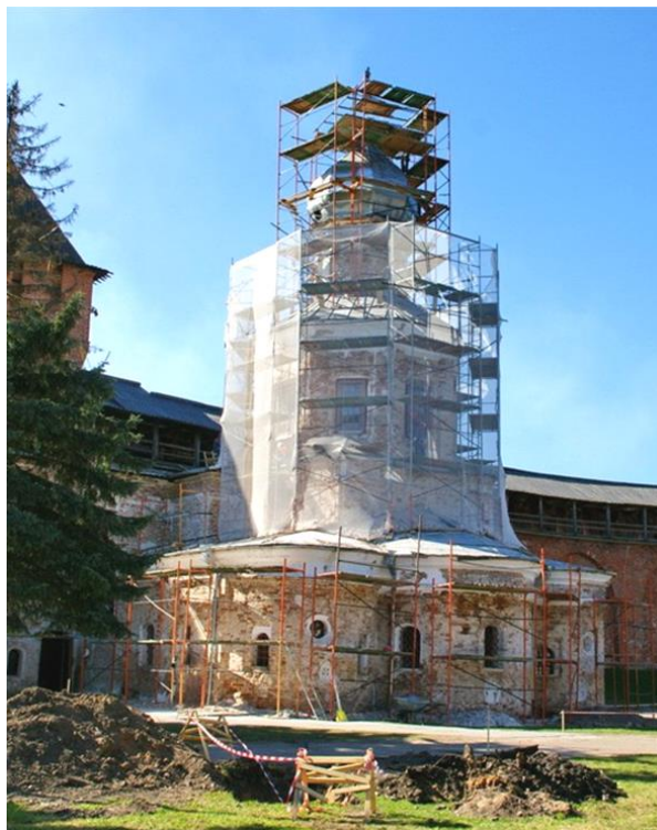
Рис. 8. Церковь Покрова Богородицы. Вид с юго-востока в процессе проведения ремонтно-реставрационных работ, 2009 г.
